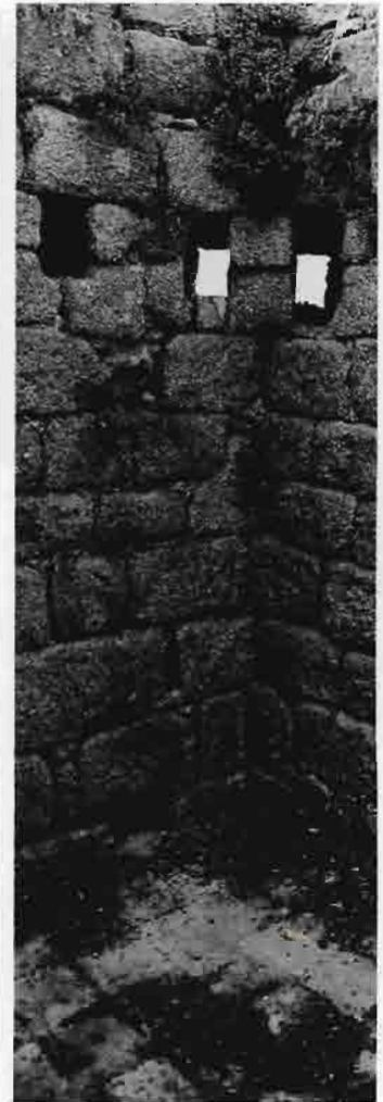
Terrat de la torre Simona
