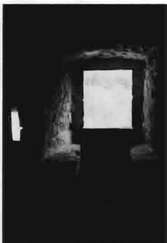
Exemple de finestra amb festejadors i amb espitllera al costat: torre del mas Espanyol
