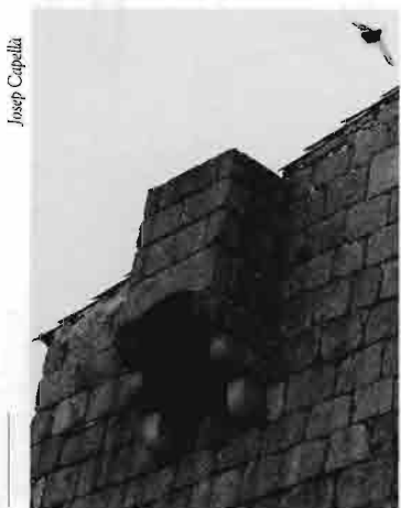
Tres mènsoles sobreposades suporten el matacà de la torre del mas Fina
