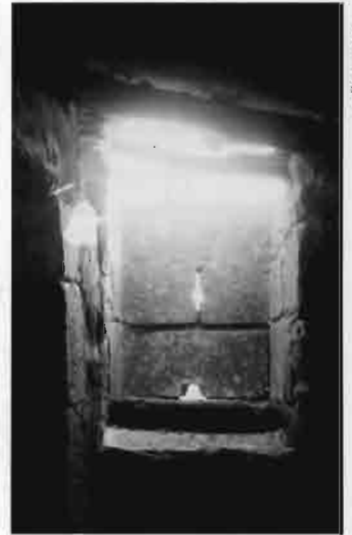
Matabacà de la torre del mas Fina vist des de l'interior. Hi podem notar dues espitlleres frontals d'arma de foc
