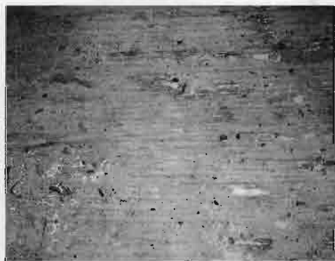
Volta de pedra amb empremta de l'encanyissat utilitzat a l'encofrat.
