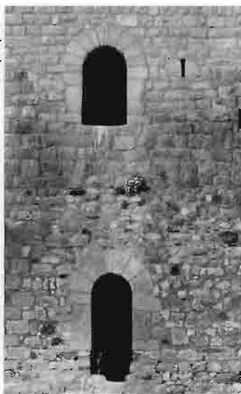
Façana principal de la torre del mas Petit d'en Caixa amb obertures adovellades de mig punt. La superior presenta una espitllera al costat
