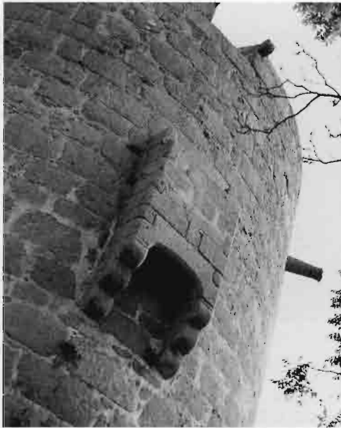
Matabac de la torre de Calella construït amb carreus de granit, a l'igual que els murs de la torre
